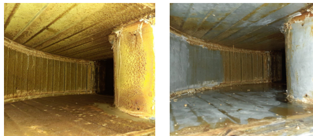
Kanalanlage vor und nach der Reinigung
